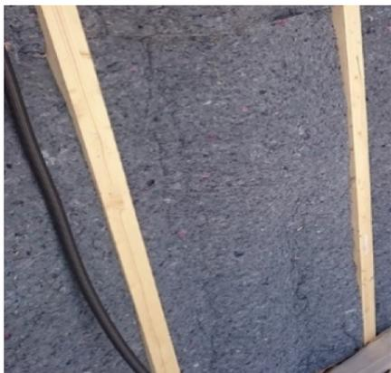
La solución acústica quedó resuelta con otro producto de la empresa, realizado también con algodón reciclado aglomerado con fibras termofusibles de 40 mm complementado con bandas acústicas, mientras que en los suelos se instaló la suela de impacto INPAT<sup>®9</sup> de 10 mm.
