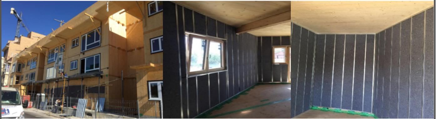
Figura 9. Aislamiento de Geopanel® en el proyecto Las Carolinas
