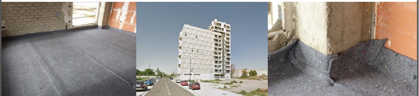
Figura 10. Lámina INPAT en el proyecto de 90 viviendas
