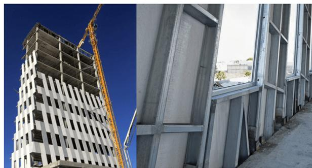
Imagen 3: Fachada Industrializada vista exterior e interior. Fuente: <https://opticaretos.com/producto/fachadas/>
