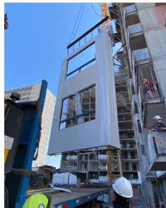
Imagen 2: Fachada industrializada. Fuente: <https://www.cdt.cl/fachadas-prefabricadas-innovacion-y-productividad/>
