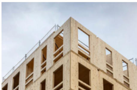
Imagen N° 1: Elevación de edificio en madera. Fuente: Madera 21 (2022).
