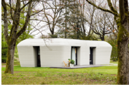
Imagen N°1 Primera casa habitada impresa en hormigón 3D del Proyecto Milestone en Bosrijk, Eindhoven, por a.o. Theo Salet TU/e Fuente: Plataforma de Arquitectura (2022).
