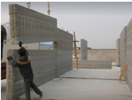
Imagen N°2: Montaje de un muro. Fuente: ArchDaily (2014).
