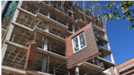
Imagen N°5: Montaje de paneles de fachada en Valencia. Fuente: Housage (2021).
