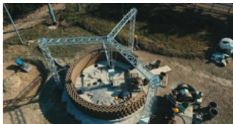
Imagen N°1: Fabricación Casa TECLA, Massa Lombarda 60 m<sup>2</sup>. Fuente: Issuu, 2024.
