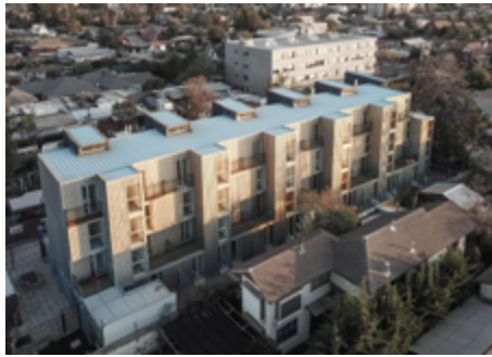
Imagen N°4: Container Building. Fuente: Hsu-Rudolph - Arquitectura (2022).
