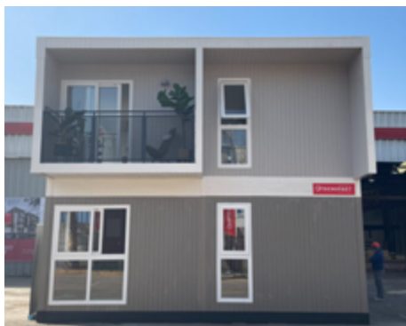
Imagen N°2: Edificio Tecno Fast Proyecto Lo Espejo. Fuente: Tecno Fast (2024).
