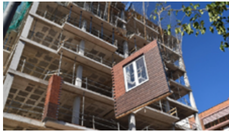
Imagen N°5: Montaje de paneles de fachada en Valencia. Fuente: Housage (2021).
