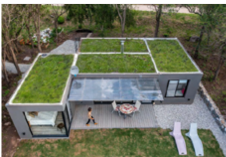
Imagen N°2: Vivienda incorpora terrazas verdes que mejoran la aislación acústica y genera un impacto sobre la temperatura interior. Fuente: Magnone, lavoz (2024).
