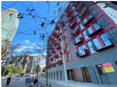
Imagen N°1: Edificio de vivienda de emergencia del ayuntamiento de Barcelona. Europapress (2022).
