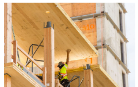
Imagen N°2: Brock Commons Tallwood House. Fuente: KKLaw; Los paneles prefabricados ayudan en la eficiencia de un proyecto.
