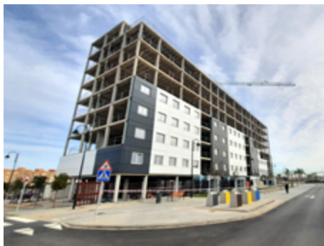
Imagen N°1: Fachada industrializada Quart de Poblet en Valencia. Fuente: Grupo Lobe (2024).
