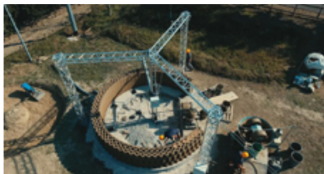
Imagen N°1: Fabricación Casa TECLA, Massa Lombarda 60 m 2 . Fuente: Issuu, 2024.
