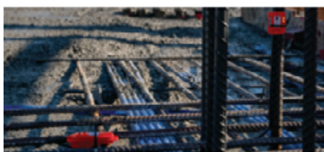
Imagen N°2: Sensores de hormigón HCS T1. Fuente: Hilti (2024).
