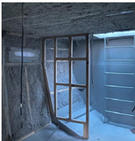
Imagen N°2: Aislación de celulosa proyectada en vivienda. Fuente: Thermikhaus (2024).
