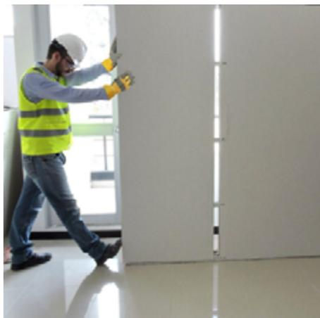
Imagen N°3: Montaje tabique prearmado. Fuente: Romeral (2024).
