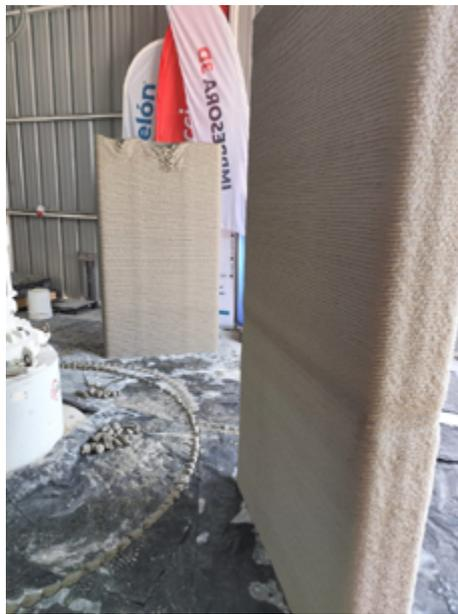
Imagen N°3: Impresión muros altura máx 2,50 metros. Fuente: CTEC (2024).
