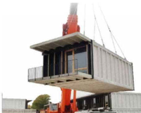
Figura 2. Módulos volumétricos 3D (3D volumetric modules). Universidad del País Vasco.
