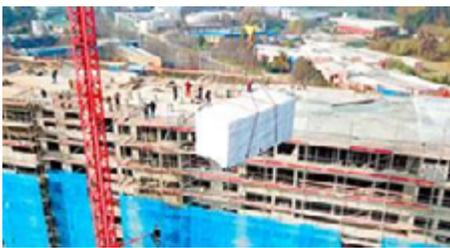
Imagen N°1: Montaje sala de caldera modular. Fuente: BOETEK (2023).
