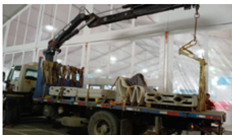
Imagen N°1: Traslado y montaje piezas 3D en Edifica 2024 (Fuente: Melón)
