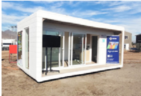
Imagen N°1: Módulo Net Zero - Construye Zero en Parque de Innovación CTEC. Fuente: INVES.
