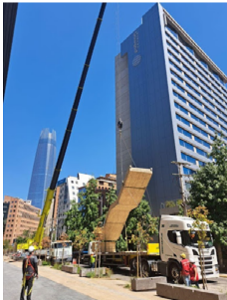
Imagen N°6: Traslado y montaje escaleras MUT - Mercado Urbano Tobalaba. Fuente: Madera 21, 2023.
