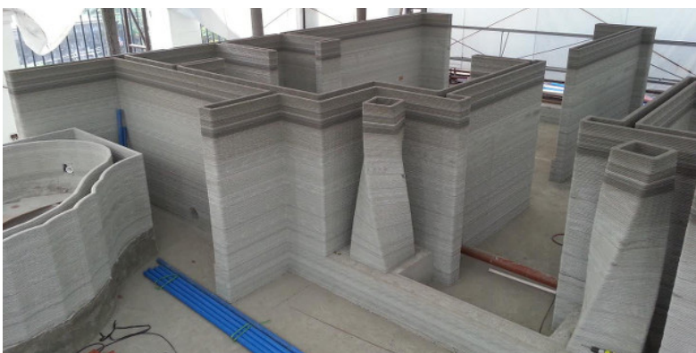
Imagen N°3: Impresión 3D en hormigón. Fuente: 3D natives, 2016.
