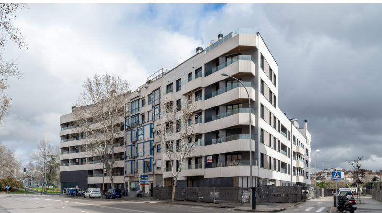
Imagen N°2: 101 viviendas, Madrid. Fuente: Lignum Tech, 2025.
