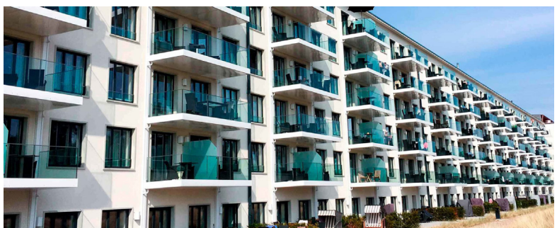
Imagen N°2: Rehabilitación de viviendas (después). Fuente: Rehabiterm, 2025.
