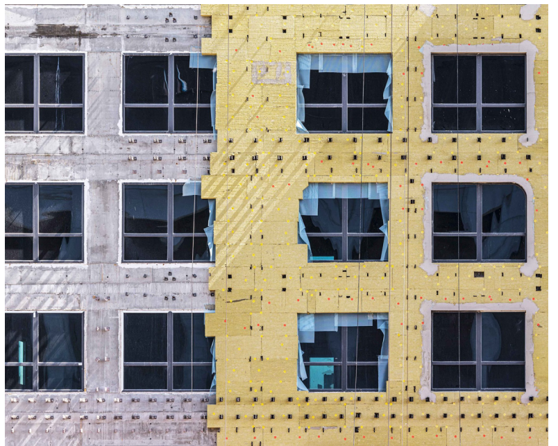
Imagen N°3: Rehabilitación de viviendas. Fuente: Rehabiterm, 2025.
