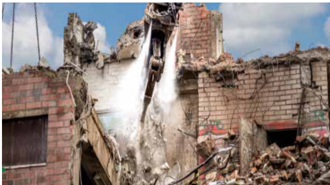
Imagen 1: Equipos demolición con pulverizadores de agua. Fuente: Alamy, 2017.
