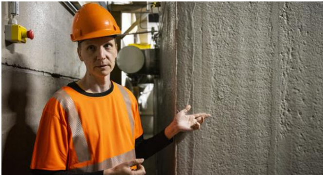
Imagen N°2: CEO de Carbonaide en la fábrica de prefabricado Fuente: Kauppalehti
