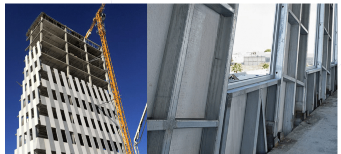
Imagen 3: Fachada Industrializada vista exterior e interior. Fuente. www.opticretos.com/producto/fachadas
