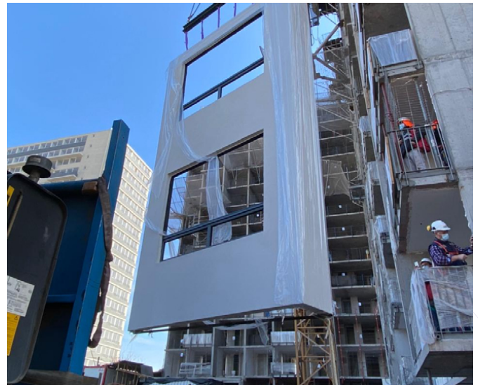
Imagen 2: Fachada industrializada. Fuente. www.cdt.cl/fachadas-prefabricadas-innovacion-y-productividad
