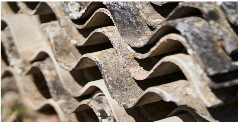
Imagen 2. Residuos de Construcción y Demolición (RCD).
